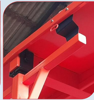
Tôle de maintien en position du toit
