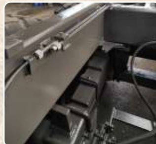
Circuit hydraulique en tube rigide
